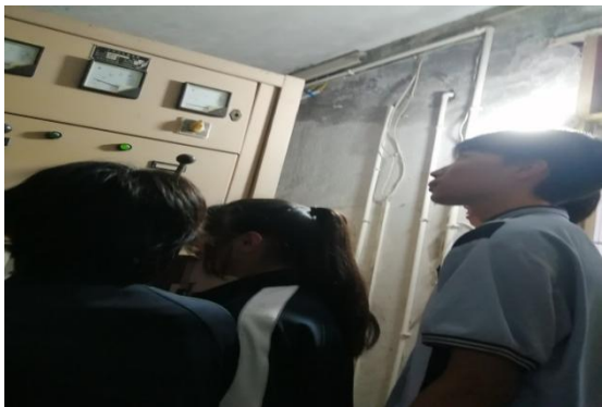
（学生观察配电房干路总开关及电流电压指示表）
